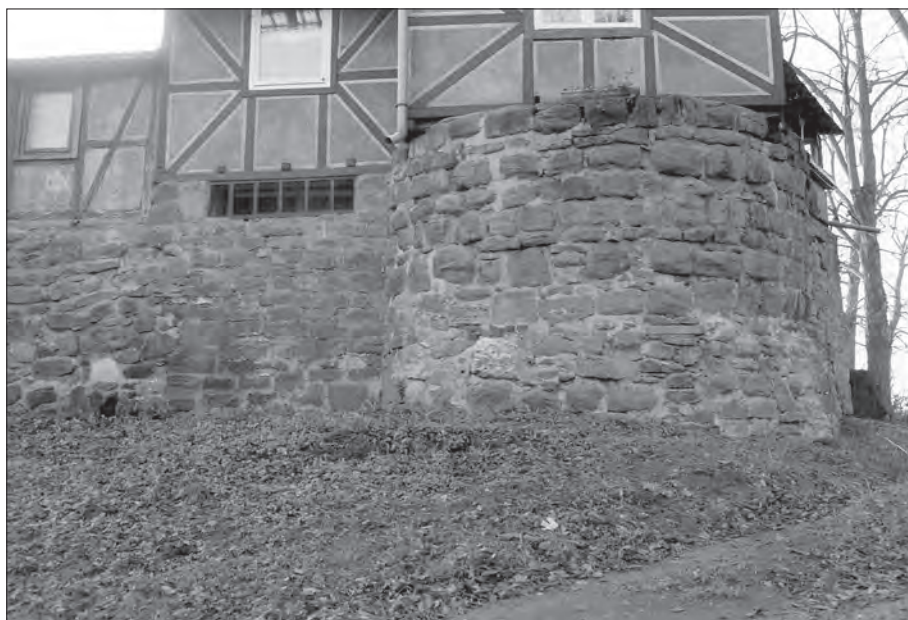
Abb. 6: Eckturm der Stadtbefestigung am Klausberg. Runder Turmstumpf mit Fachwerküberbauung
