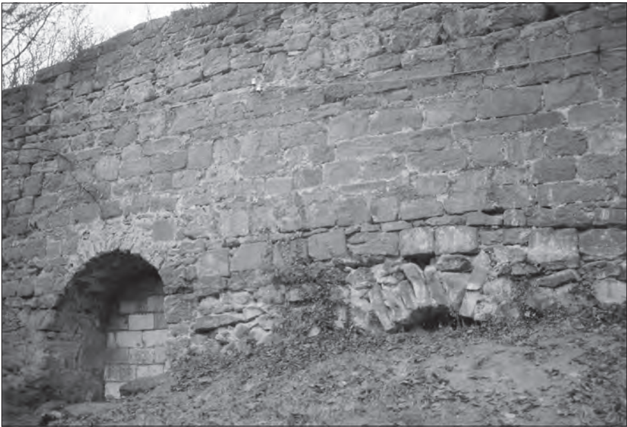
Abb. 5: Vermauerter Durchgang zum Felgentor in der Mauer am Kurpark
