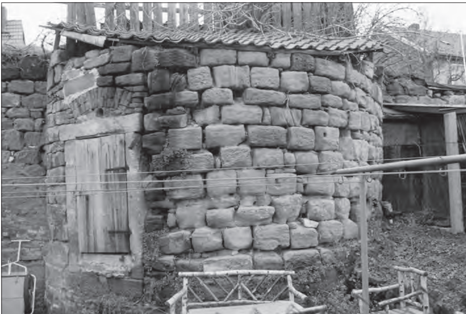
Abb. 2: Geschützturm der Mauer an der Windischen Gasse auf dem Grundstück Robert-Koch-Straße 17
