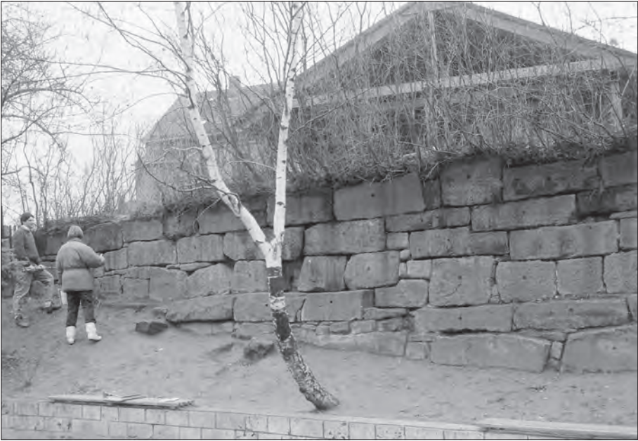
Abb. 3: Mauer auf dem Schulhof der Bergschulen „St. Elisabeth“. Zyklopenhafte, lagerhafte große Sandsteinblöcke
