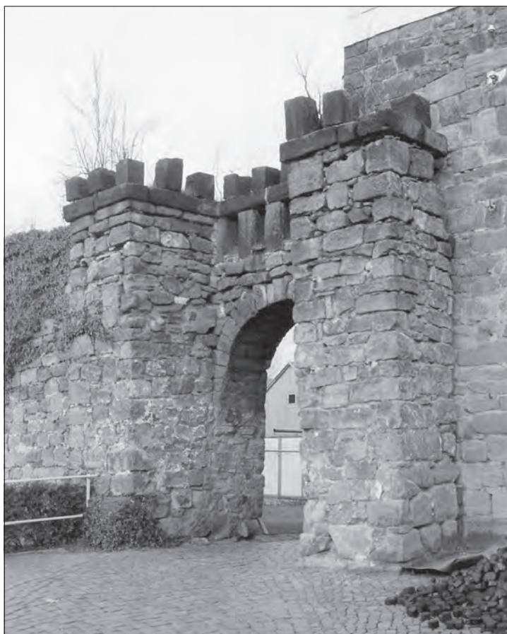
Abb. 4: Durchgang zum Garten des Bergklosters. Vorgesetzte Pfeiler und Balustrade als spätere Zutat
