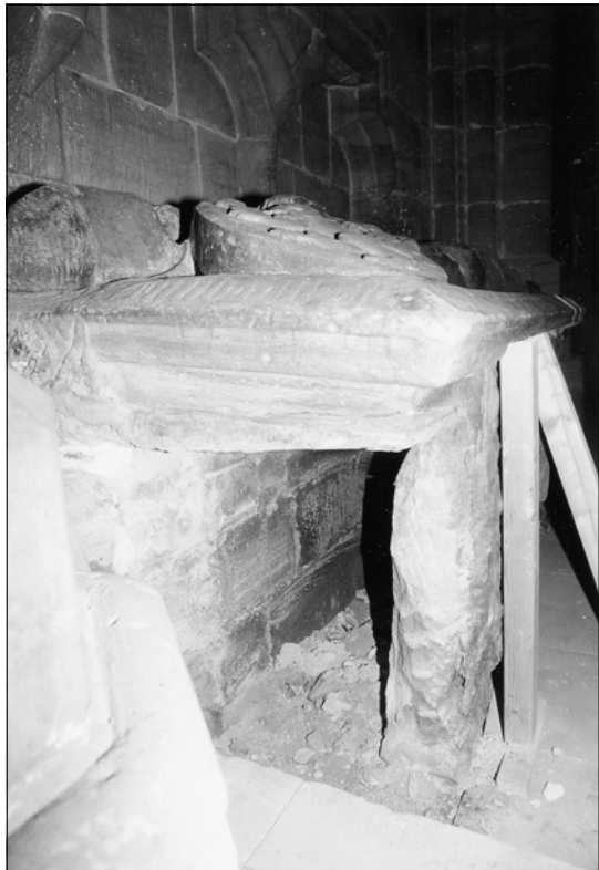
Abb. 4: Zustand nach Entfernung des östlichen Werksteins. Blick in das Innere des Sarkophags
