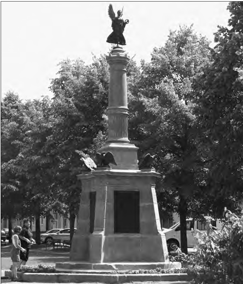
Abb. 17: Das Kriegerdenkmal erstrahlt nach der Sanierung im Juli 2008 in neuem Glanz. Foto: Anne Severin, Heiligenstadt.
