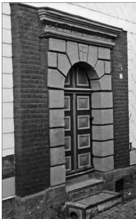
Abb. 2: Gebäudeeingang am Werner-Martin-Weg.
