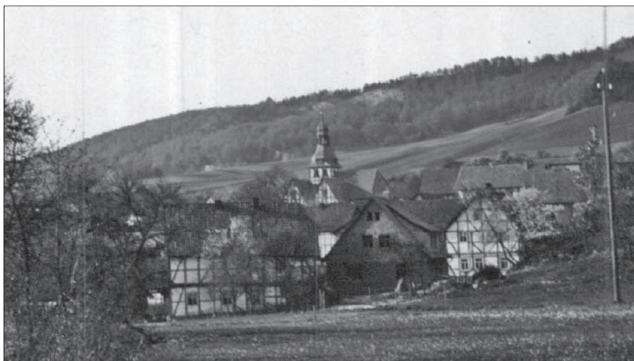
Abb. 10: Die ehemalige Obermühle (Fachwerkhaus links), 1930. Quelle: PFA Mackenrode.
