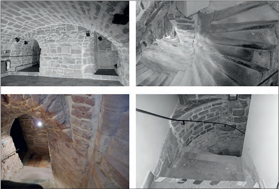
Abb. 6: Links oben: Südschildwand mit Zugang in Verbindungsgang; links bzw. zum Treppenaufgang rechts; links unten: Blick von oben in Treppenaufgang, Antrittskammer T1; rechts oben Blick von oben in Treppenaufgang, Aufsicht mit Treppenkernel T2 und T3; rechts unten: Treppenaustritt T4 in das erste Geschoss mit angepasstem Wangenmauerwerk. Fotos: K. A. Heidenblut.
