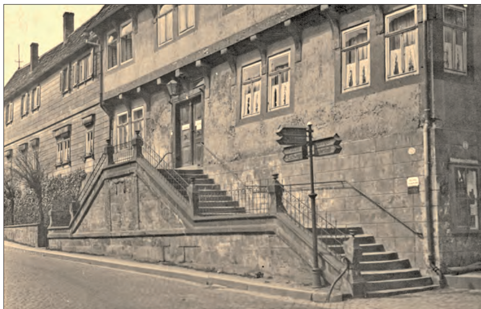
Abb. 19: Mainzer Haus mit Freitreppe von 1840 und Putzbekleidung von Fachwerk und Sockelgeschoss, Paneelverkleidung der Marstall-Ostfassade. Perspektivische Ansicht um 1900. Sammlung W. Prochaska.
