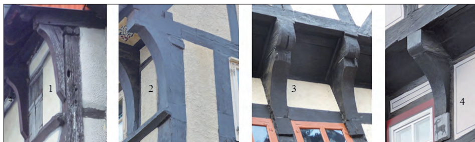
Abb. 9: Regionale Bügen-Ausführungsunterschiede: Bild 1: Grebenstein; Bild 2: Duderstadt, Apothekerstraße; Bild 3: Stollberg, Ritterstraße; Bild 4: Heiligenstadt, Mainzer Haus. Fotos: K. A. Heidenblut.
