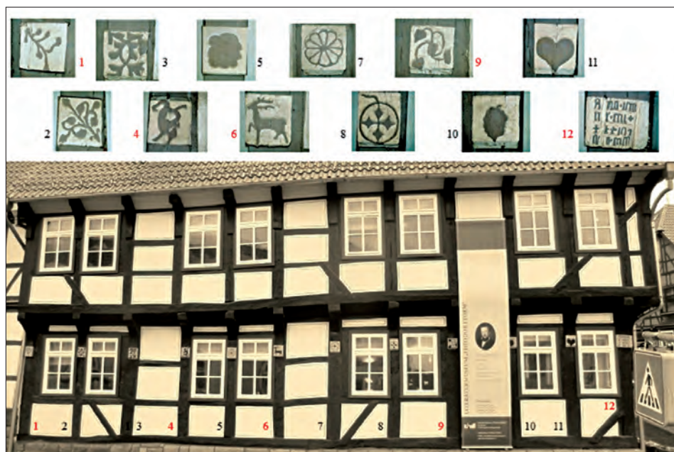
Abb. 11: Oben: Reliefdarstellung an Ständerauflagern für die Bügen der Auskragungskonstruktion. Fotos der Auflagerpunkte: Antje Pohl; unten; Ostfassade als Abbild der Stockwerkkonstruktion des Mainzer Hauses, 1. Stockwerk mit durchgängiger Nummerierung der Fassadenständer. Fotos: K. A. Heidenblut.
