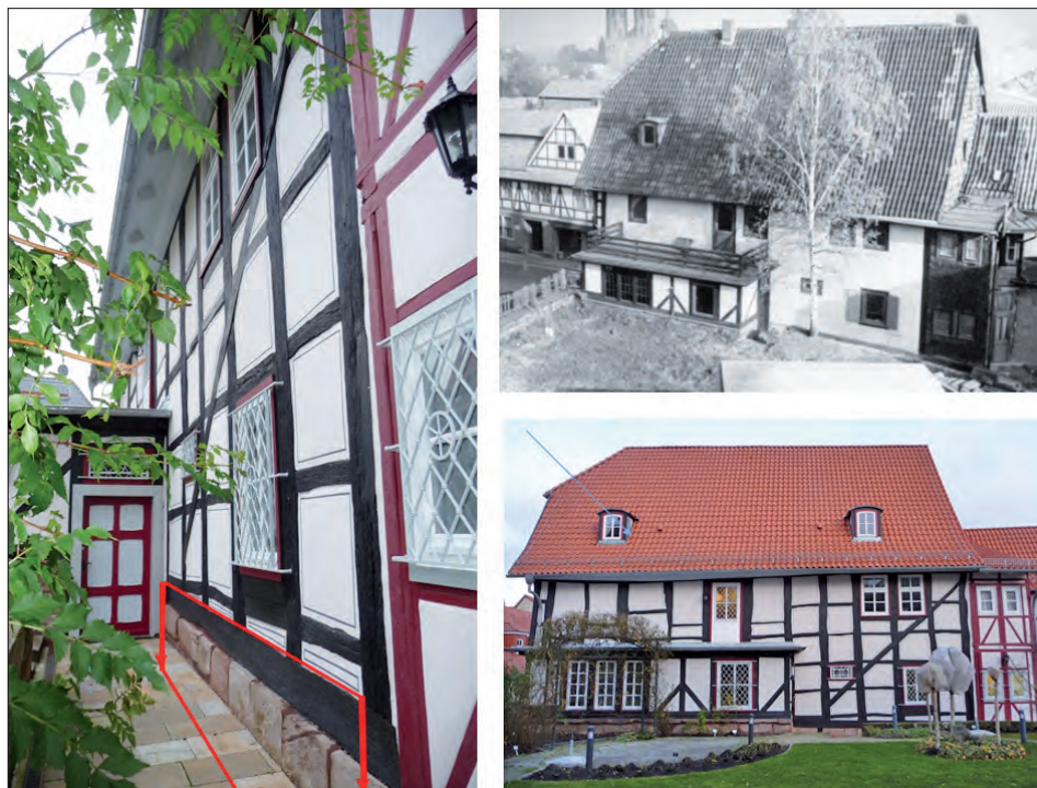
Abb. 27: Links: Ausschnitt der West-Ständerfassade, rot eingezeichnet die Veränderung der Schwellenlage mit Ständerkürzung. Rechts oben: Blick von Südosten auf den geräumten Garten- und Hofbereich mit noch verputzter Westfassade des Mainzer Hauses. Foto: E. Jüngel. Sammlung Eichsfelder Heimatmuseum. Rechts unten: Blick von Westen auf die zweigeschossige Ständerfassade. Fotos: K. A. Heidenblut.
