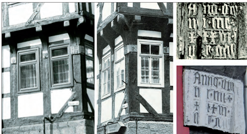
Abb. 13: Links: Eckständer mit drei Eckbügen, Zustand nach 1975. Foto: TLDA. Mitte: Eckständer w. v., Zustand um 1970. Foto: Lücke. Rechts oben: Büгенаuflager Ostseite, Zustand vor 1960. Foto: W. Prochaska. Rechts unten: Büгенаuflager Ostseite, Zustand 2012. Foto: K. A. Heidenblut.
