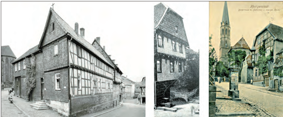
Abb. 23: Links: Marstall mit Südflügel im Bauzustand um 1900. Foto: K. A. Heidenblut (1968). Mitte: Nordgiebel des Mainzer Hauses mit vorgelagertem Garten. Rechts: Bergaufgang; nahe dem heutigen Standort des Storm-Denkmal befand sich ein öffentlicher Brunnen (um 1900). Sammlung G. Klingebiel.
