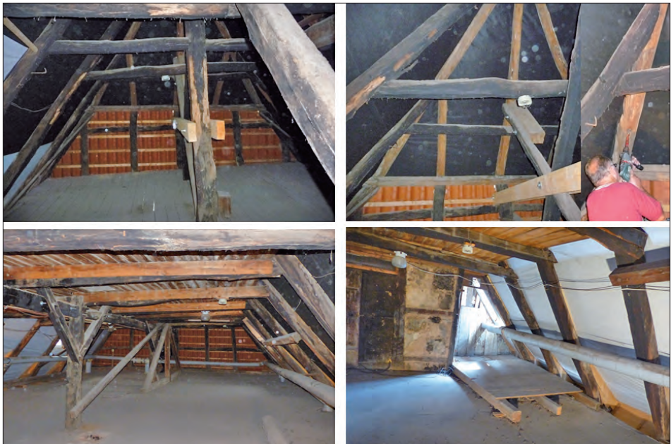
Abb. 15: Blick in den Dachboden. Links unten: Dachboden unter der untersten Kehlbalkenlage Richtung Nordgiebel. Links oben: Dachboden oberhalb der Kehlbalkenlage. Rechts oben: Krüppelwalmausbildung am Nordgiebel. Rechts unten: Blick zum Südgiebel mit abgedecktem früherem Treppenaufgang und Bodenkammern. Fotos: K. A. Heidenblut.
