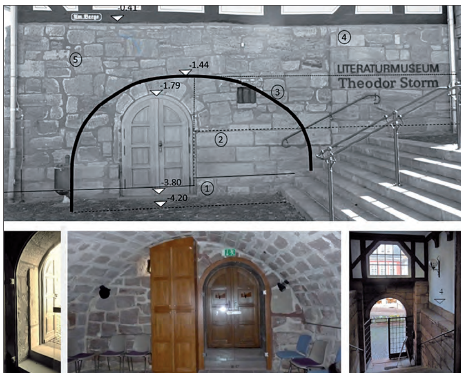
Abb. 5: Oben: Nordgiebel des Sockelgeschosses; unten links: Gewände- u. Bogendetail der Pforte I; unten Mitte: Nordschildwand des Gewölbekellers A; unten rechts: Sockel im Eingangsbauwerk von 1935, Oberkante wie Höhe des vorgeblendeten Sockels (4) am Nordgiebel. Fotos: K. A. Heidenblut.
