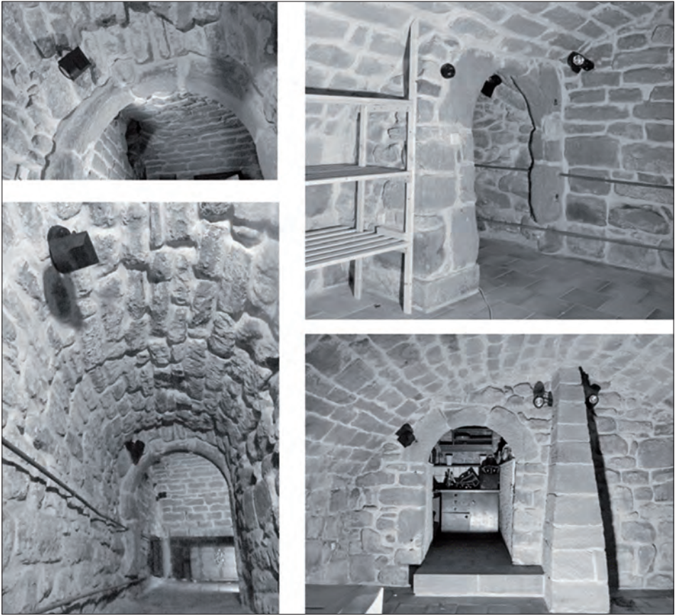
Abb. 4: Links unten: Blick in den Verbindungsgang C von Norden; links oben: Naht am Südennde des Verbindungsganges mit Resten eines früheren Gewölbes vor Pforte II; rechts oben: Pforte II in Verbindungsgang als Teil eines eingeschobenen Mauerblocks; rechts unten: Westschildwand mit Pforte III zur Kellerhalskammer D, neben der Pforte nachträglich vorgesetzter Stützpfeiler. Fotos: K. A. Heidenblut.
