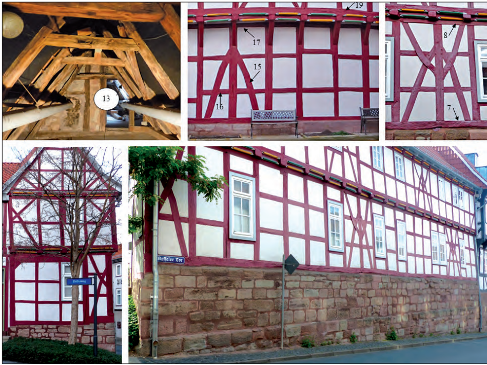
Abb. 18: Dendrochronologische Untersuchungen und Aussteifungskonstruktionen am Marstall. Oben links: Dachabbund. Oben Mitte: Halber Mann an der Hoffassade. Oben rechts: Wilder Mann an der Ostfassade. Unten links: Südgiebel. Unten rechts: Ostfassade. Fotos: K. A. Heidenblut.
